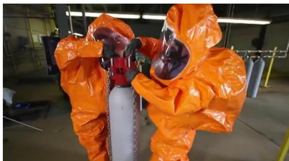
En el caso que exista una fuga por deterioro del cuerpo de la botella, lo primero que se debe hacer es girarla de forma que el producto escape en fase gas y no en fase líquida, y a continuación utilizar los útiles y accesorios que dispone el kit para este tipo de fugas.
