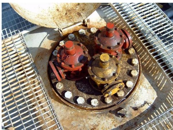
Cisterna de cloro, domo y válvulas de fase gas y líquida.
