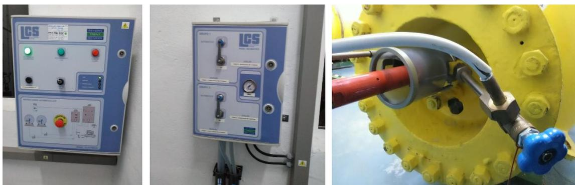
Sistema LCS para automatizar el corte del suministro en caso de fuga de gas cloro
